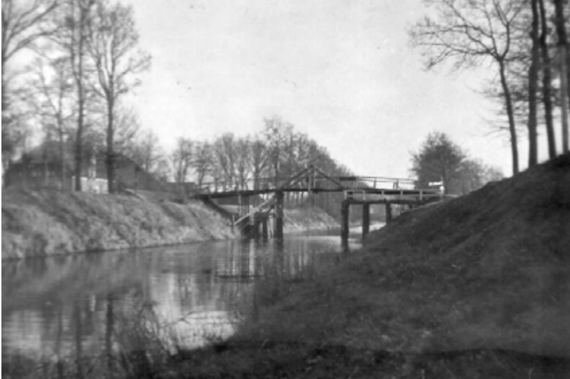
De noodbrug bij Kalteren.
